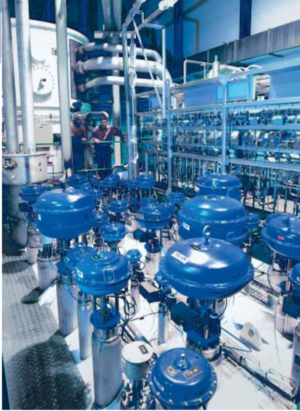
配有西门子阀门定位器的低温阀门
