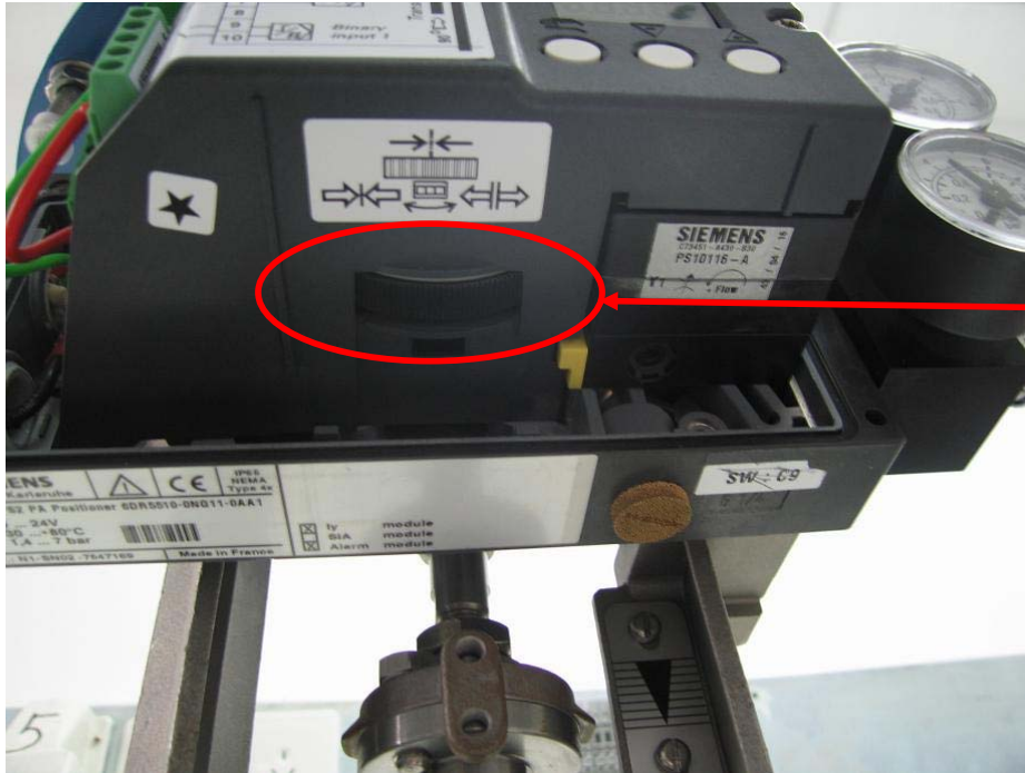
滑动夹紧装置的 调节轮
